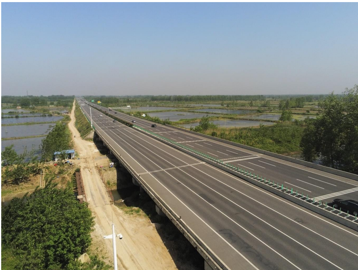
桥梁工程区监测点位（军民渠大桥）
