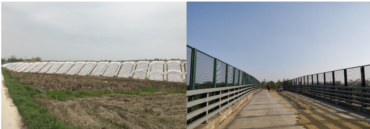
改移工程区监测点（GK578+382 车行天桥）
