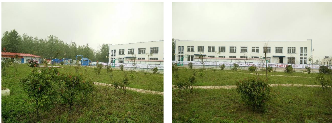
施工场地区 5 标项目部绿化监测样地
