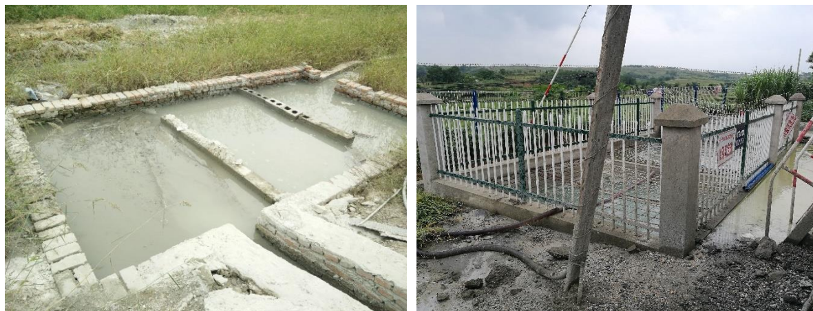
施工场地区2标拌合站沉沙池法监测点
