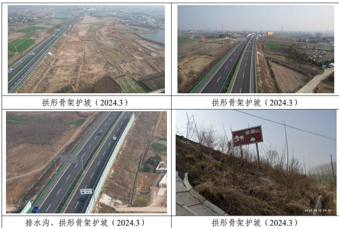
图 4.1-1 水土保持工程措施照片
