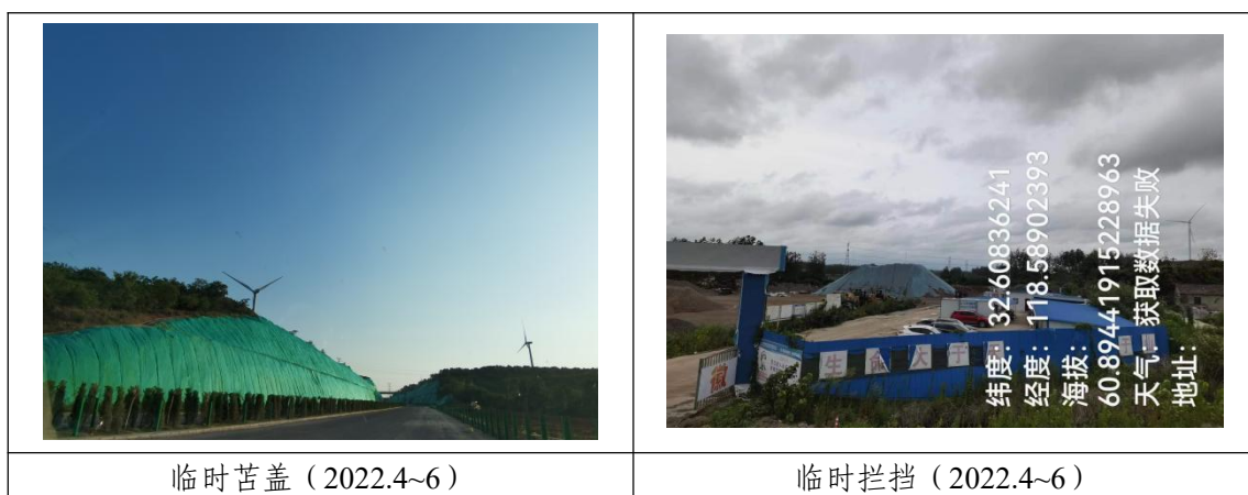
图 4.3-1 临时措施照片
