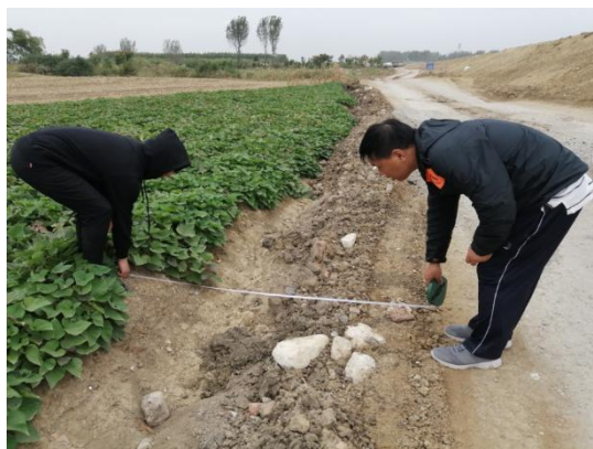
K1+000 施工道路一侧临时排水沟
