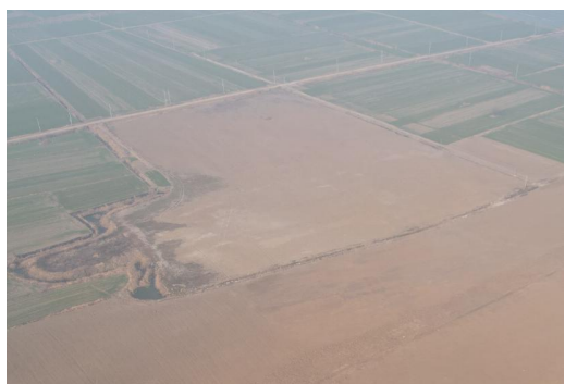
施工场地土地整治
