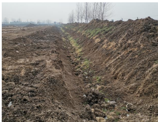
淮上区取土场外围排水沟
