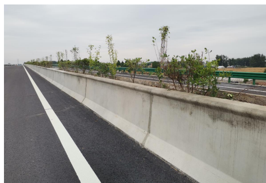
中央分隔带内土地整治
