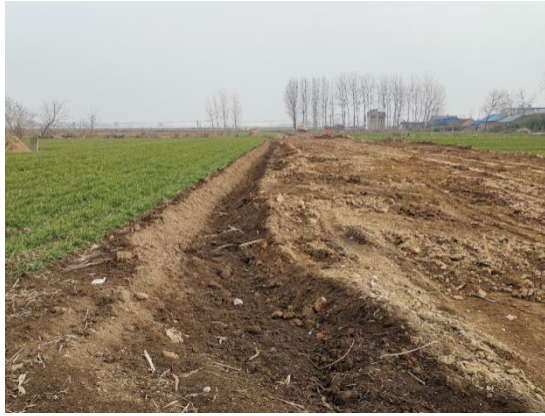
2 标 7#取土场施工便道一侧土质排水沟
