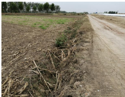
K4+000 施工道路一侧临时排水沟
