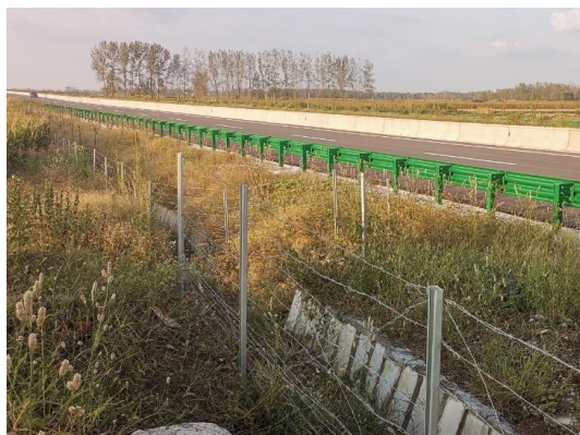
路基边坡土地整治
