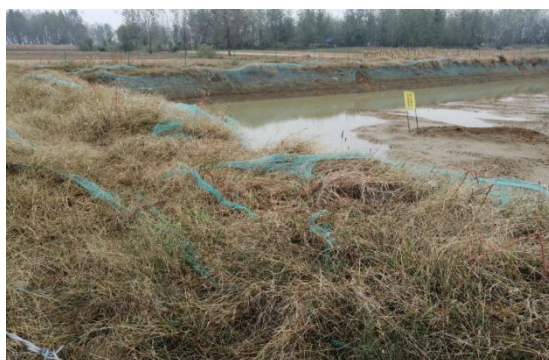
取土场外围堆土边坡密目网苫盖、自然恢复
