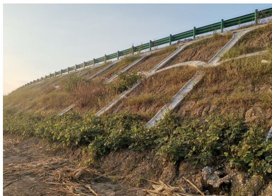
路基边坡拱形骨架护坡
