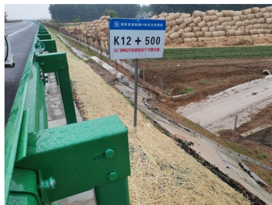
K12+500 路基边坡草帘苫盖
