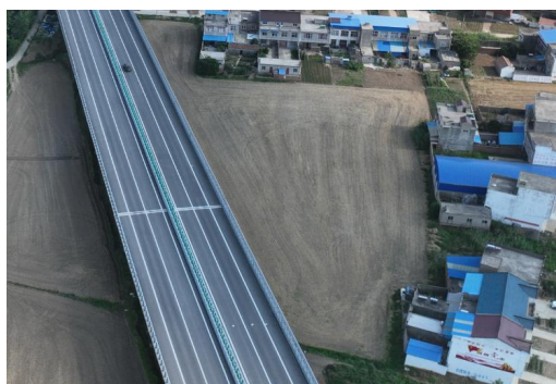
临时堆土区土地整治
