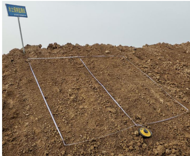
路基边坡水土保持监测点
