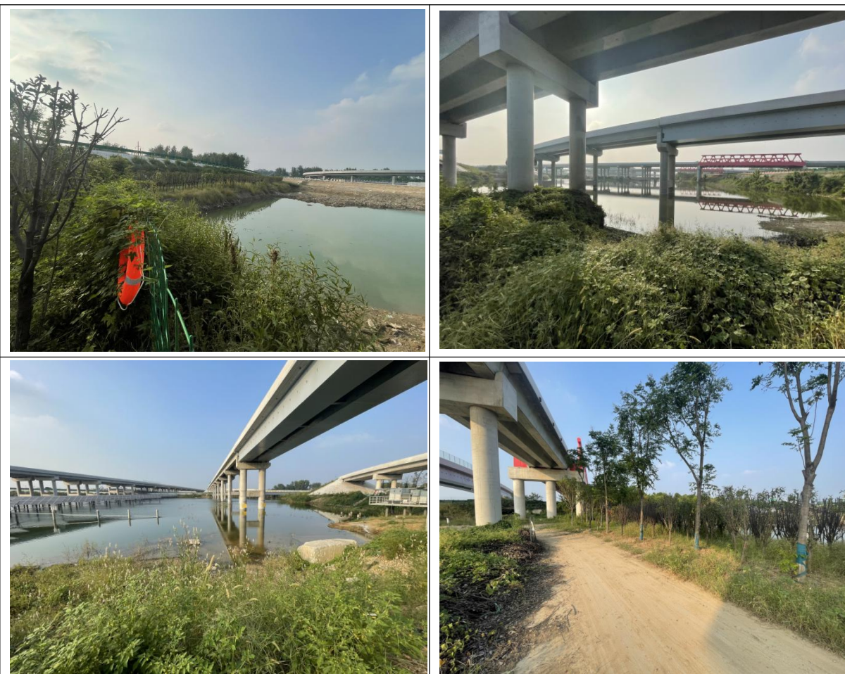
4#取土场现状恢复照片
