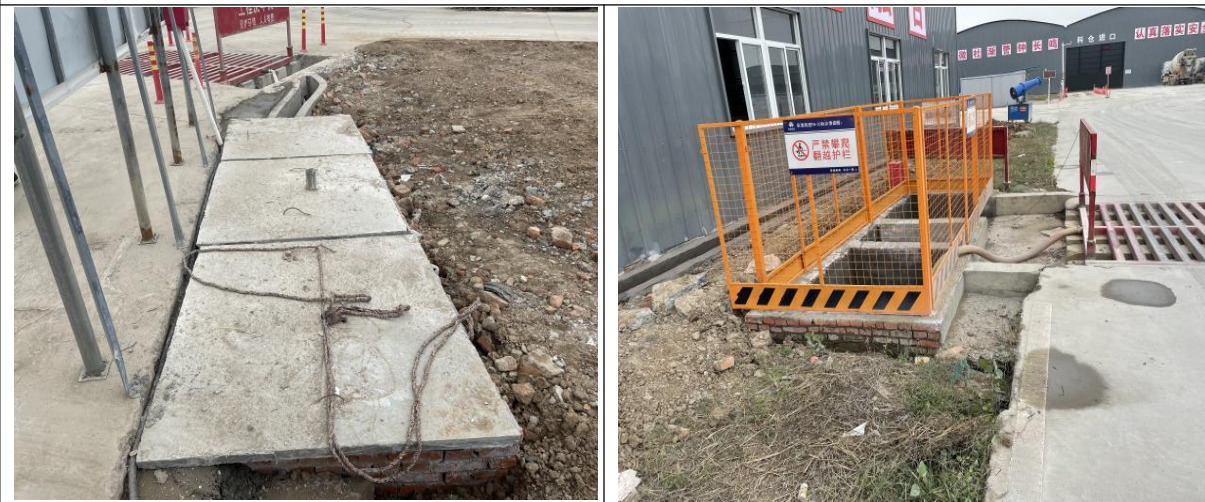
施工生产生活区内部临时沉沙池
