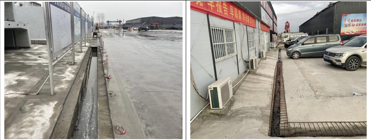
施工生产生活区内部临时排水沟
