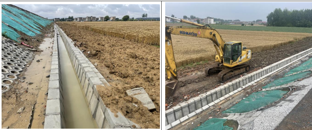
施工道路平整（2023 年 6 月）
