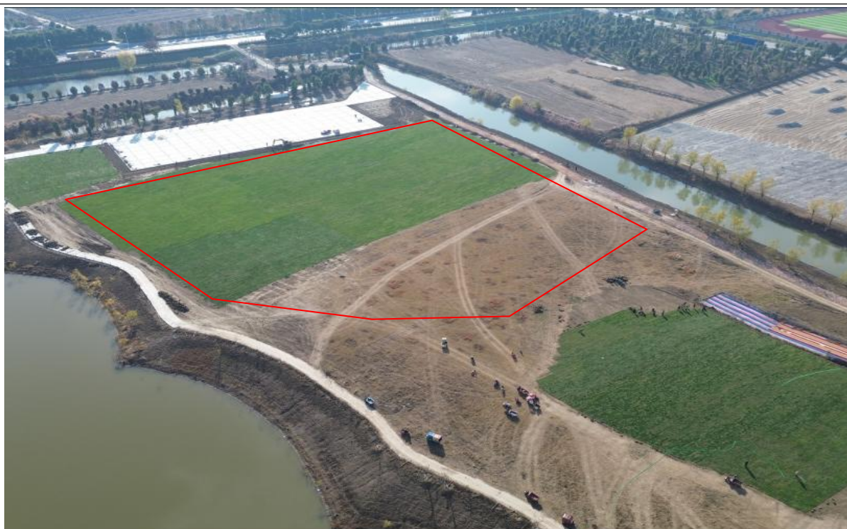
3#取土场现状恢复照片
