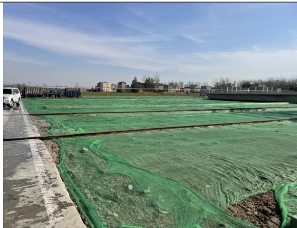
施工生产生活区临时苫盖
