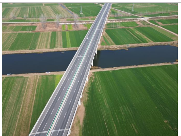
洪河分洪道特大桥
