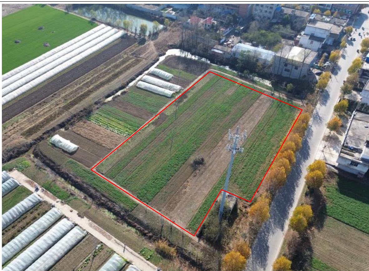
2 标 1#表土堆场现状
